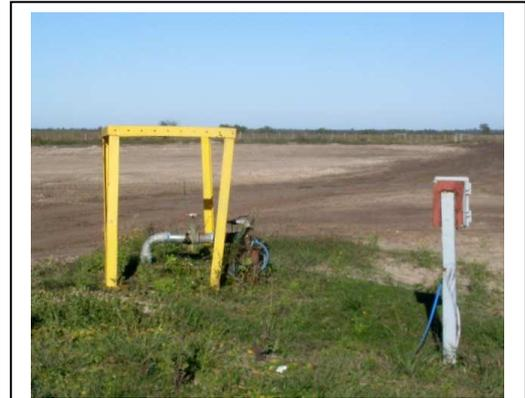
Fig 19. Cabezal del pozo de agua existente en el predio
